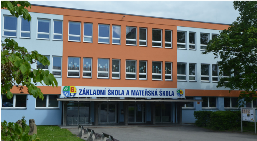
ZŠ Jilemnického - příklad realizace snižování energetické náročnosti budov
